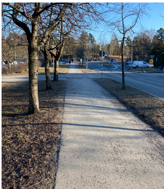
Figur 59 Del av gång- och cykelbana utmed Lejonvägen som föreslås breddas.
