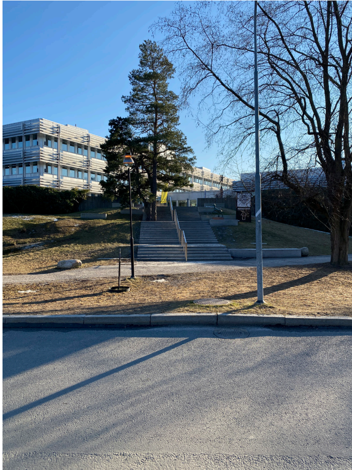
Figur 55 Befintlig gångbana och trappa söder om Bussgatan som föreslås breddas och få en kompletterande cykelbana.
