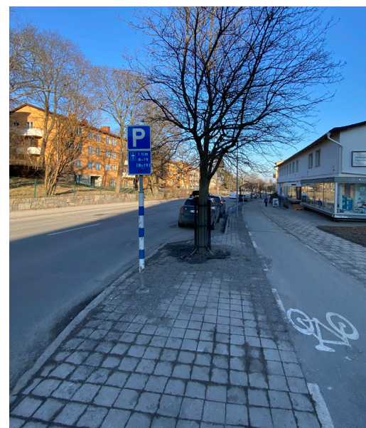
Figur 35 Befintliga parkeringsfickor utmed Stockholmsvägen som föreslås tydliggöras, få kompletterande lastfickor och ett införande av stoppförbud.
